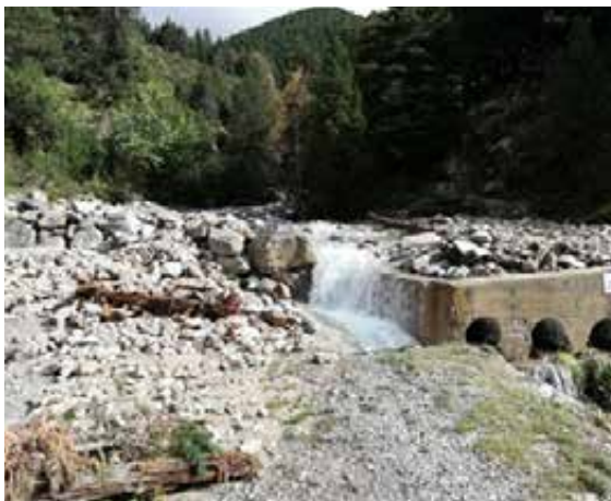
Fotografía 7. Detalle del paso de la pista por el cauce de Carboners. El agua circuló por encima de la pista, dejándola impracticable. Foto de Marta Domènech
