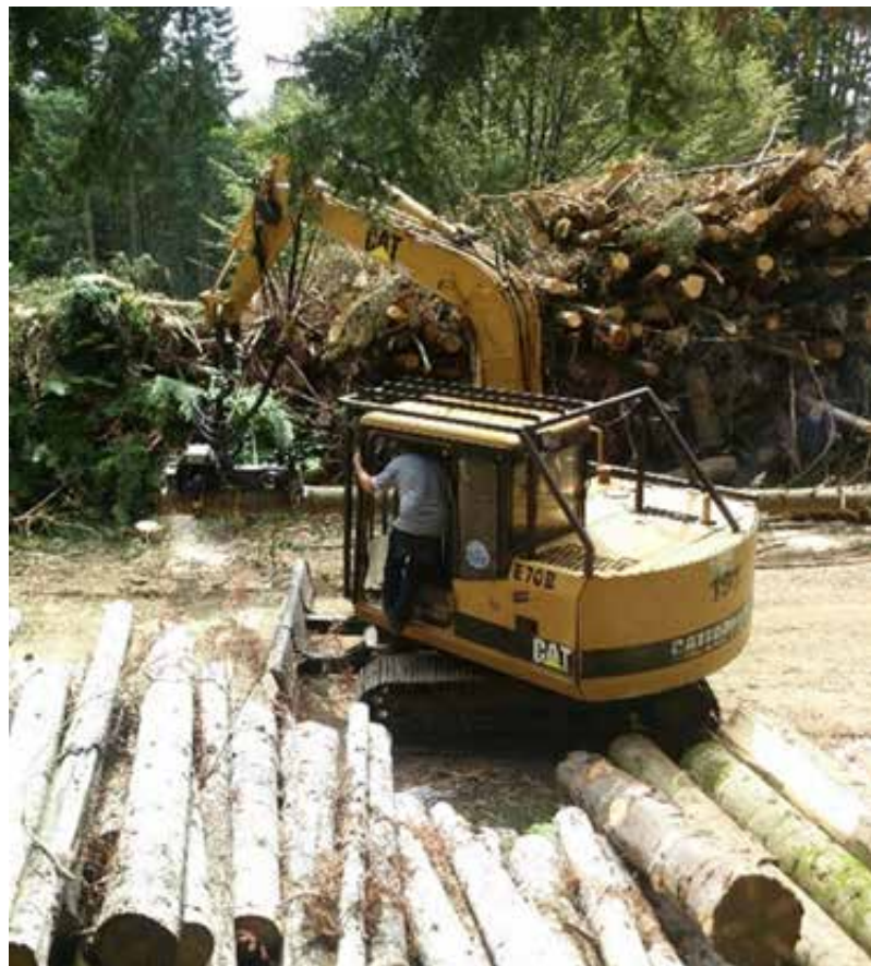
Fotografías 9 y 10. Ejemplo de excavadoras dedicadas a auxiliar la madera que llega desde los cables aéreos. Arriba una máquina con grapa equipada con motosierra cargando leña anteriormente troceada y apilada durante la saca y abajo, una pequeña procesadora forestal instalada en una excavadora de 7 toneladas.
