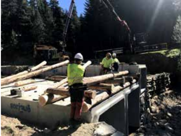
Fotografía 11. Realización de entalladuras para que todos los puntos de contacto trabajen. Foto de Montserrat Solanelles
