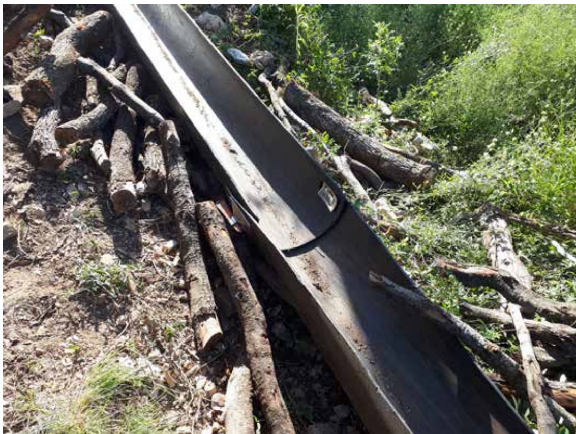
Figura 3. Detalle de la unión entre canales.
