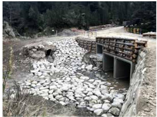
Fotografía 16. Vista general de la obra desde aguas arriba. A la izquierda de la fotografía se observa la rampa de acceso proyectada para poder hacer el mantenimiento y limpieza de la obra de drenaje transversal. Foto de Montserrat Solanelles
