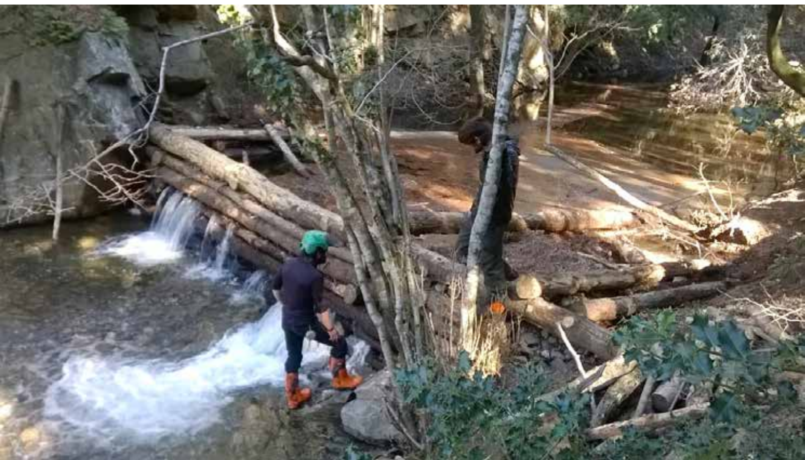
Fotografía 18. Vista de la colmatación del dique hecho con madera de castaño. Foto de Andreu González
