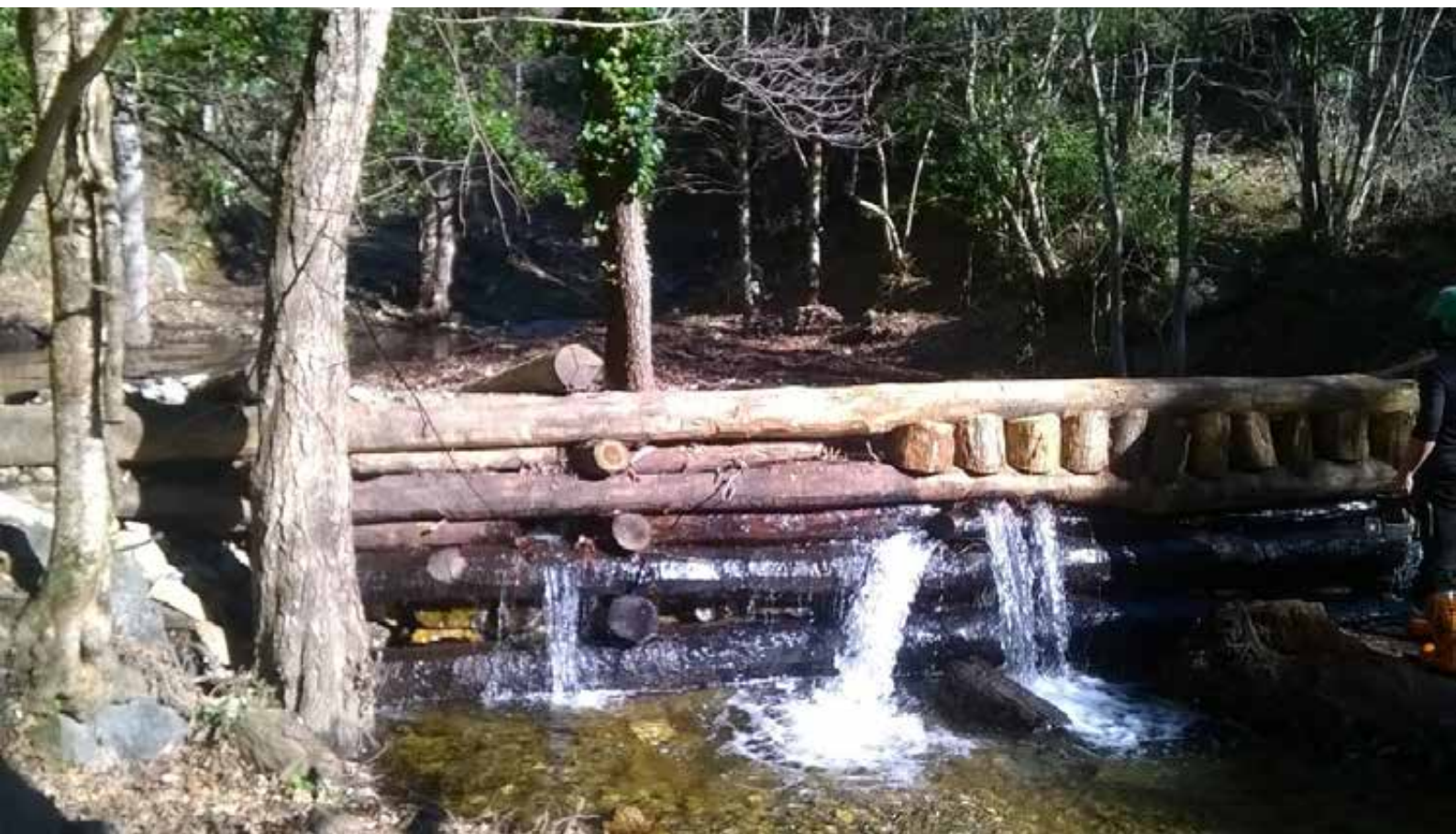
Fotografía 17. Vista frontal del dique hecho con madera de castaño. Foto de Andreu González
