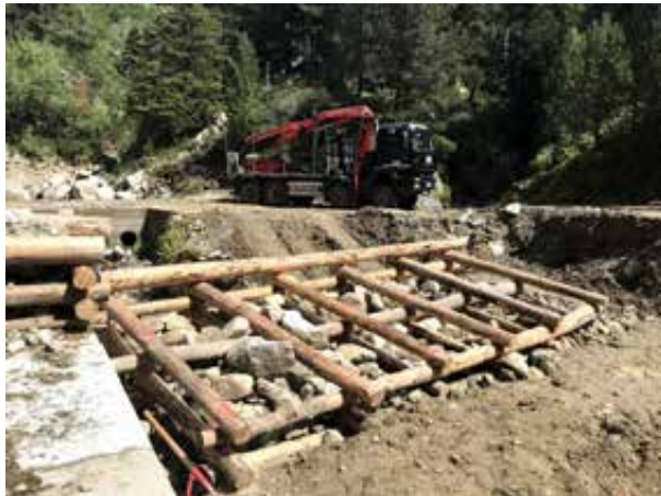
Fotografía 13. Relleno de los cajones piso a piso con piedras. Foto de Montserrat Solanelles
